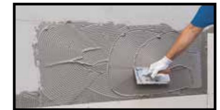
Doppia spalmatura (muratura)
