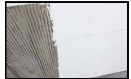
Applicazione primo strato PLANITOP HDM MAXI
