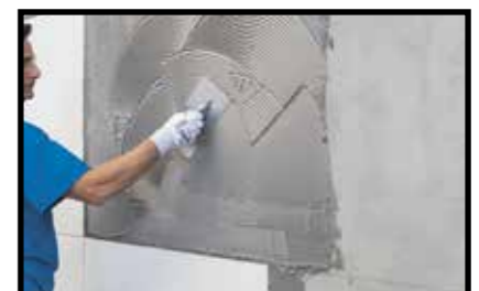
Doppia spalmatura (muratura)
