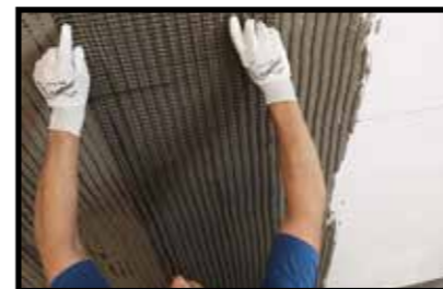
Applicazione rete MAPEGRID G120
