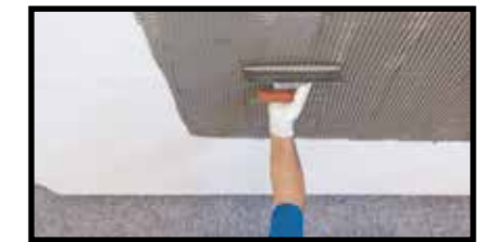
Stesura del collante con spatola dentata in senso verticale
