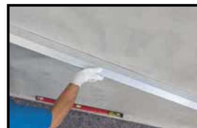
Controllo planarità dell'intonaco strutturale
