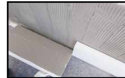
Posa dei pannelli isolanti con doppia spalmatura
