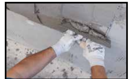
Secondo strato PLANITOP HDM MAXI
