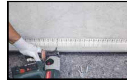
Posizionamento dei profili di partenza MAPETHERM BA
